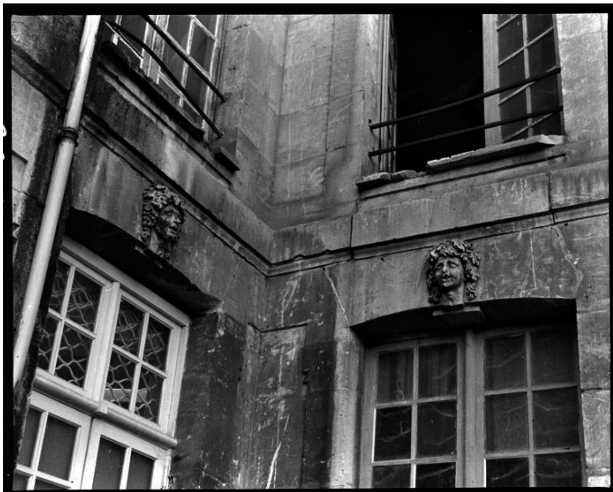
Angle du bâtiment avant la restauration.
