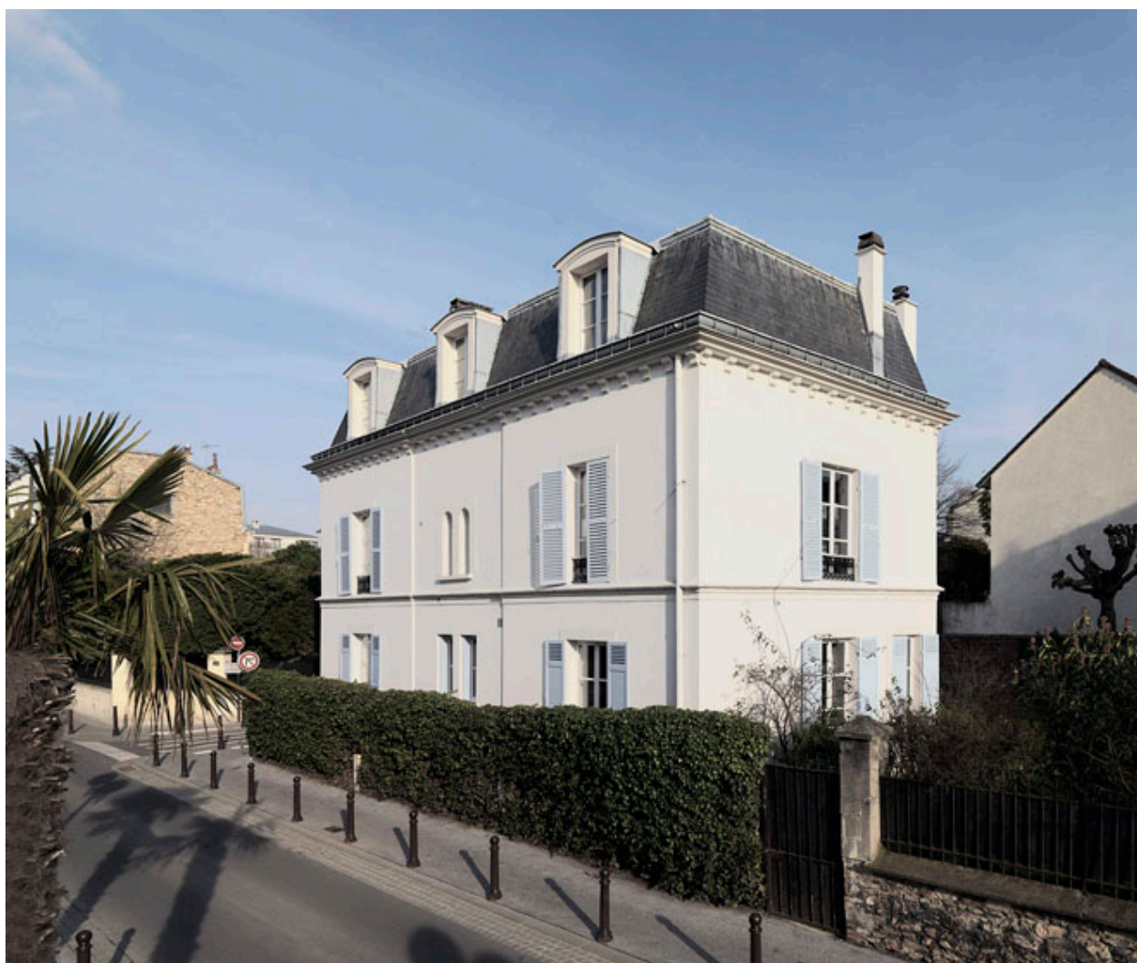
Vue d'ensemble depuis l'avenue de Ceinture.
