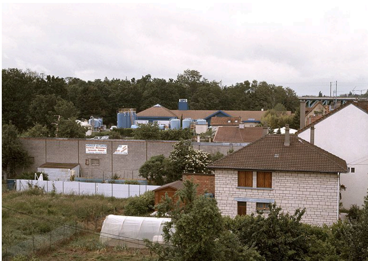
Vue d'ensemble de l'ancien emplacement de l'usine devenu l'établissement des eaux la SEFO.
