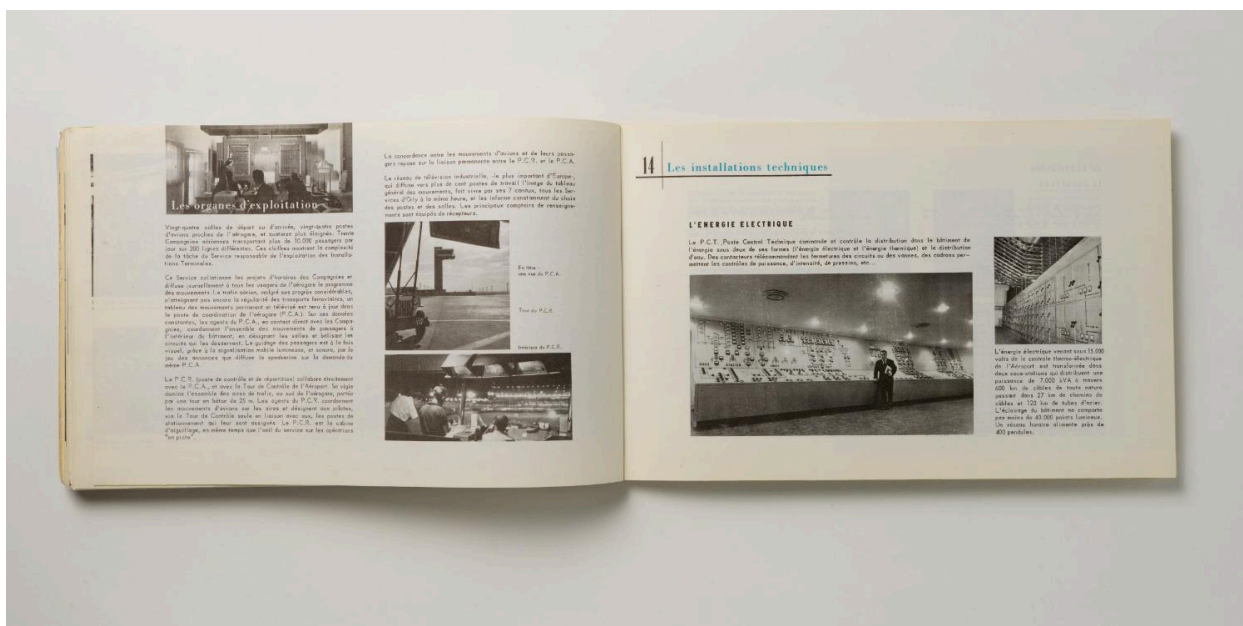
Photographie du Poste Central Technique dans "Installations Terminales Orly", brochure éditée par l'Aéroport de Paris, 1961. Île-de-France
