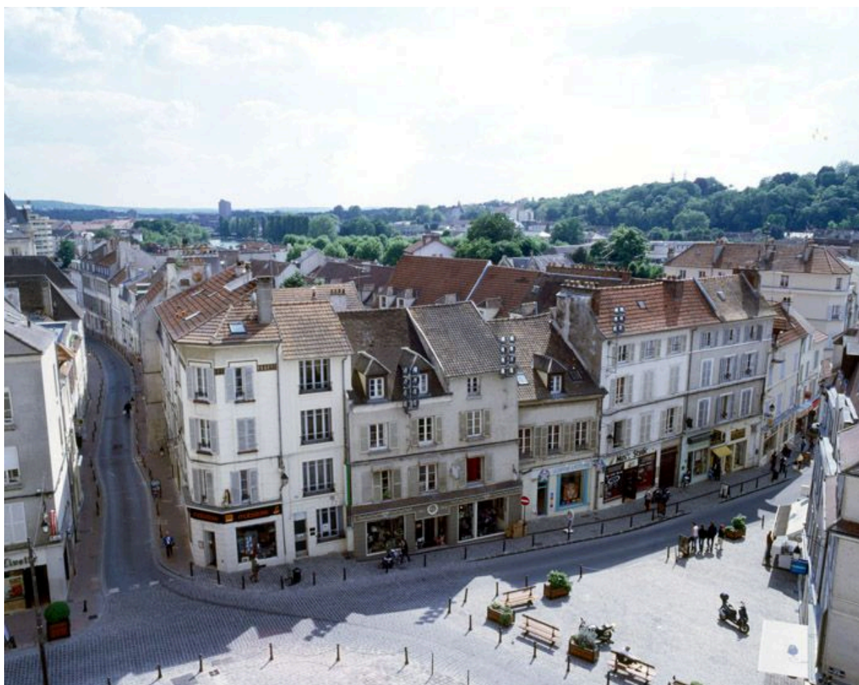
Panorama sur le parvis de la cathédrale, depuis l'échafaudage dressé pour la restauration de la base de la tour nord (2008).
