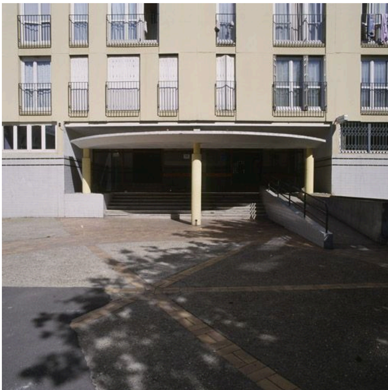
Détail de l'entrée d'une des tours.
