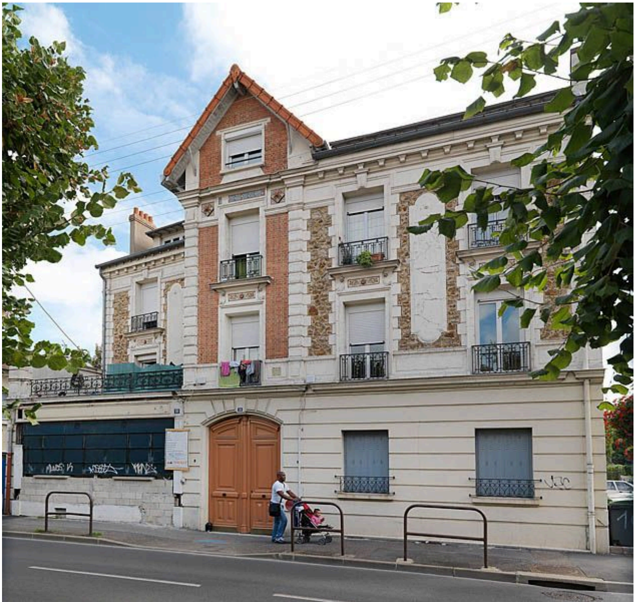
Ablon-sur-Seine, café-restaurant, immeuble, 10 rue du Général-de-Gaulle. Vue de l'élévation antérieure en 2011. On remarque des modifications intervenues sur le garde-corps de la terrasse ainsi que sur le pignon.
