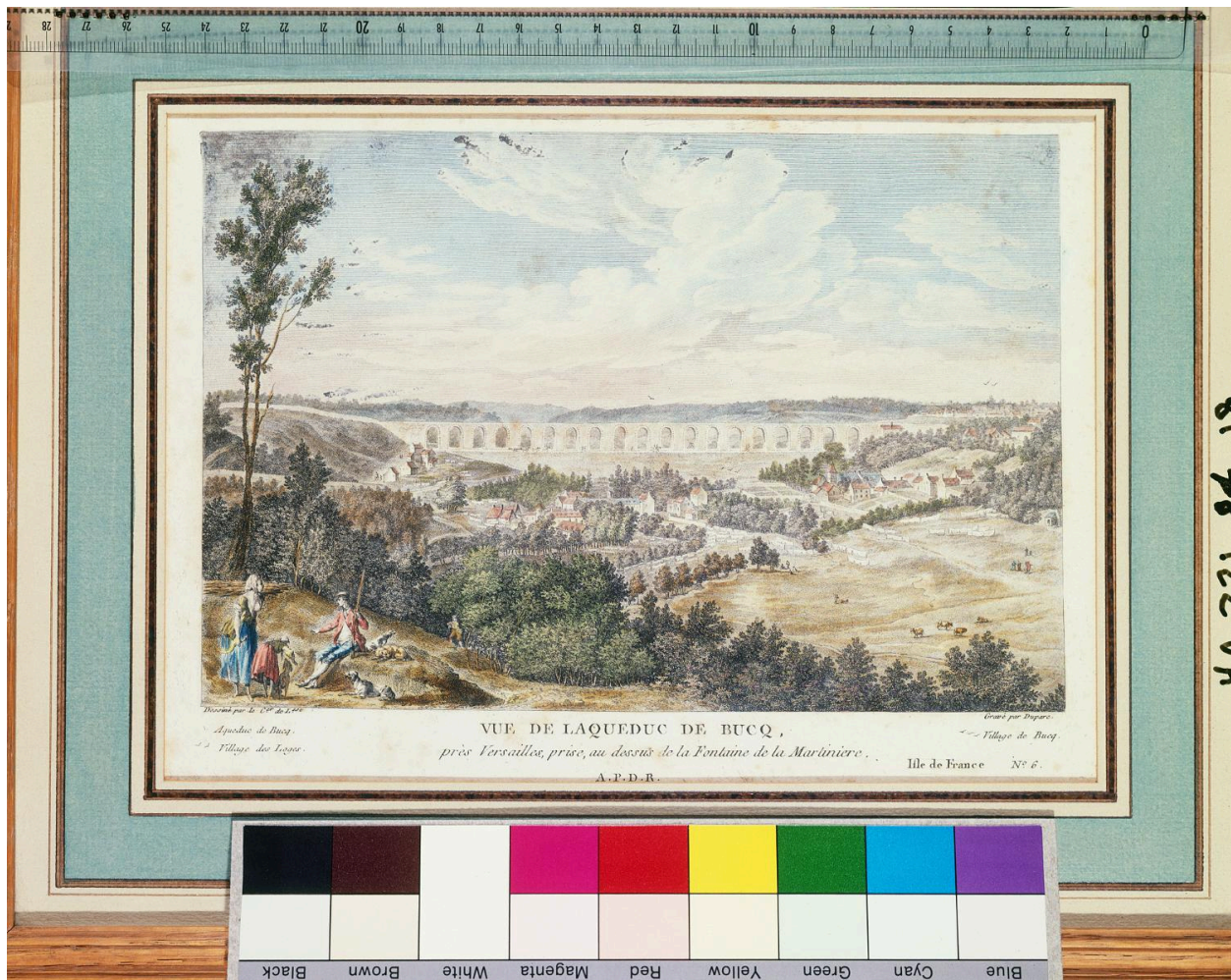
Vue de l'aqueduc de Buc.
