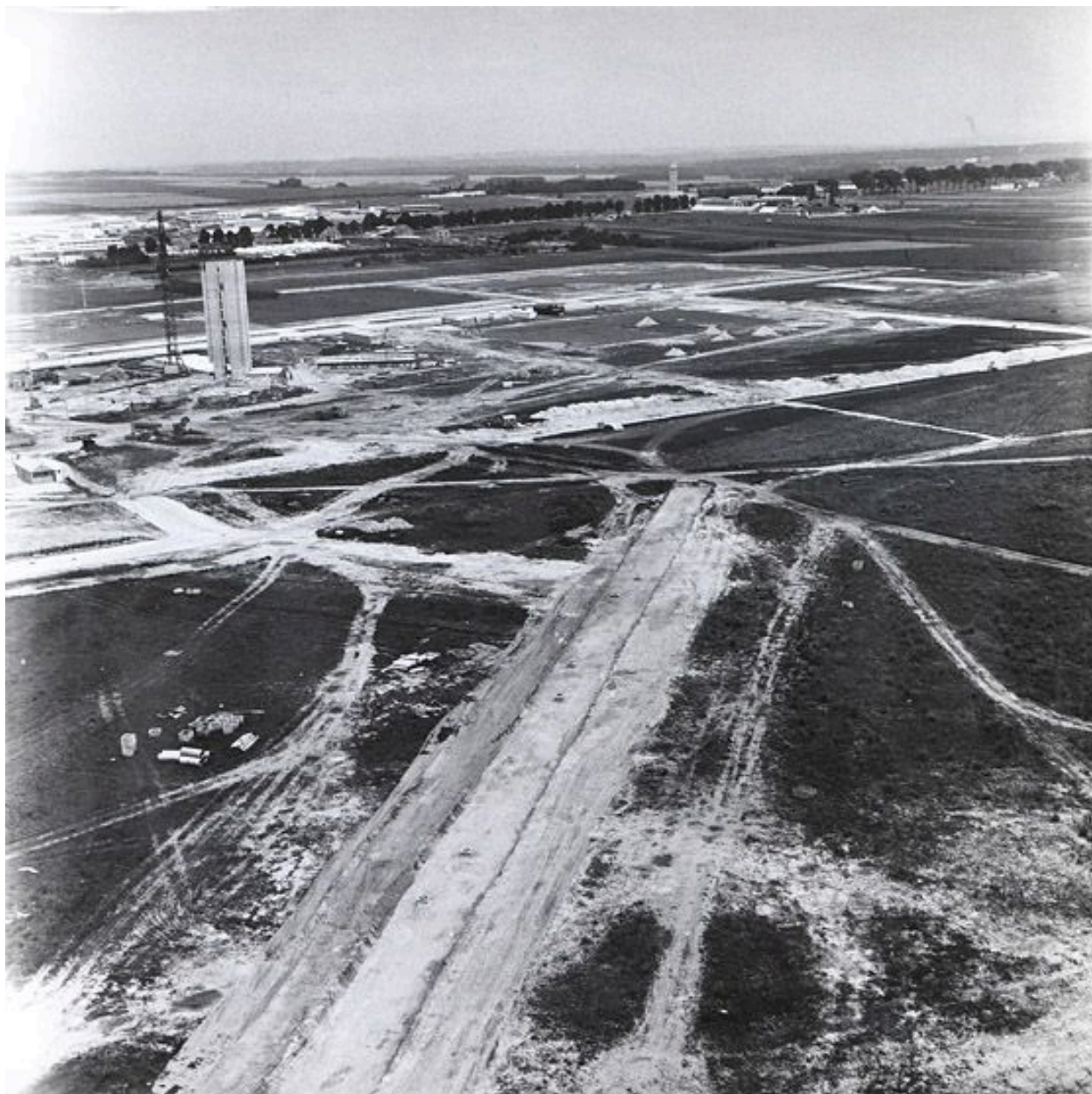
Chantier de construction d'une des tours de Beauval. Tiré de : "L'installateur", juin 1969, n° 312, p. 128, p.129 (Cité de l'architecture et du patrimoine. fonds Lods 323 AA 502-09)
