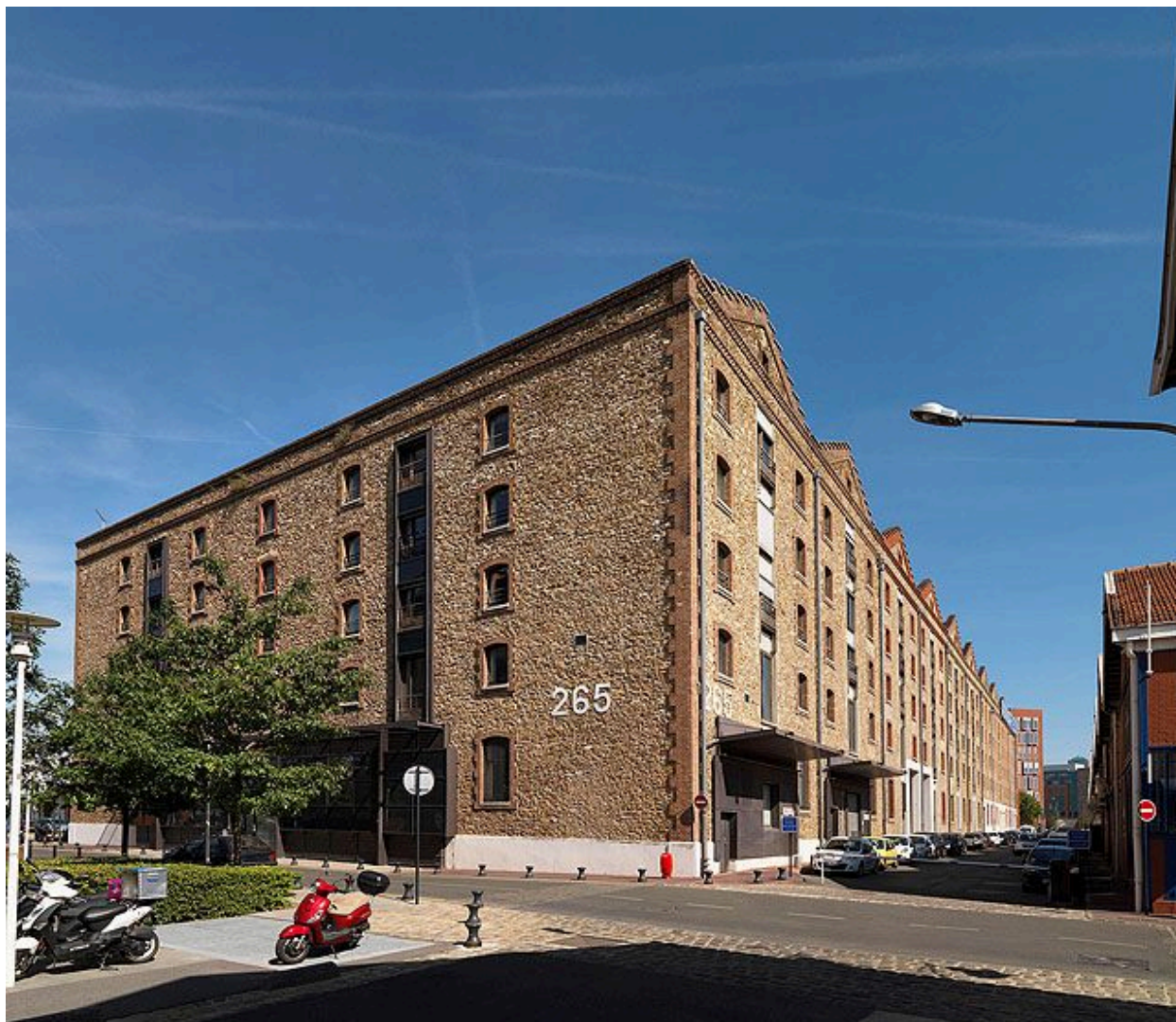
93, Saint-Denis, entrepôt commercial de la Compagnie des Entrepôts et Magasins généraux, 50 avenue Président-Wilson. Vue d'ensemble des entrepôts de meulière à nefs multiples et à pignons en pas-de-moineau (1903).
