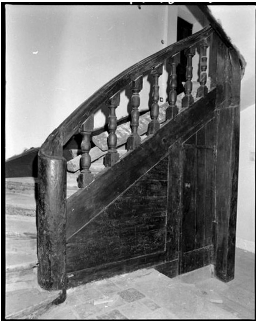
Maison, Cloître Notre-Dame (rue du) 11. Départ de l'escalier.
