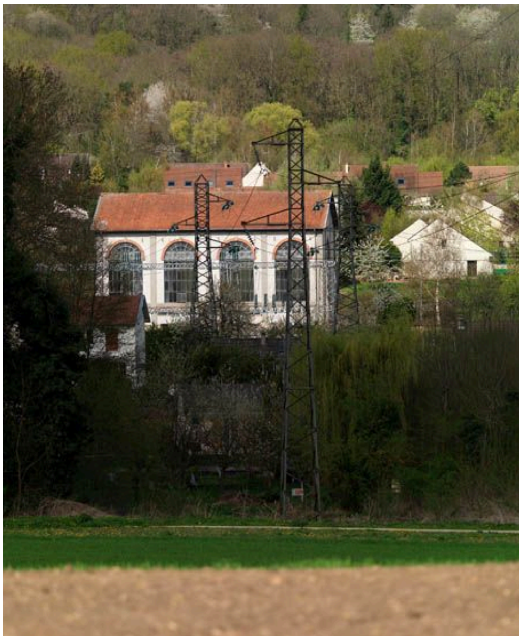
Saint-Chéron. Vue de la sous-station électrique de Saint-Evrout, depuis la rue du Vieux Châtre.
