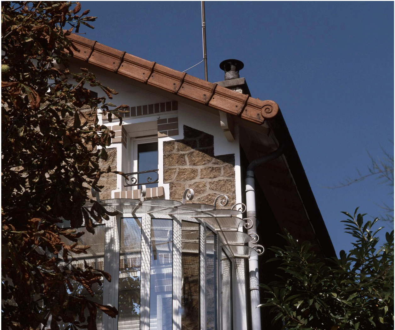
Détail d'un enduit imitant les moellons de meulière.
