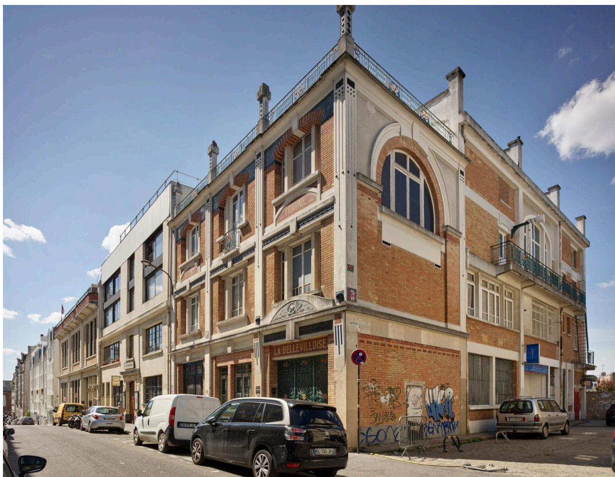
Vue générale du bâtiment
