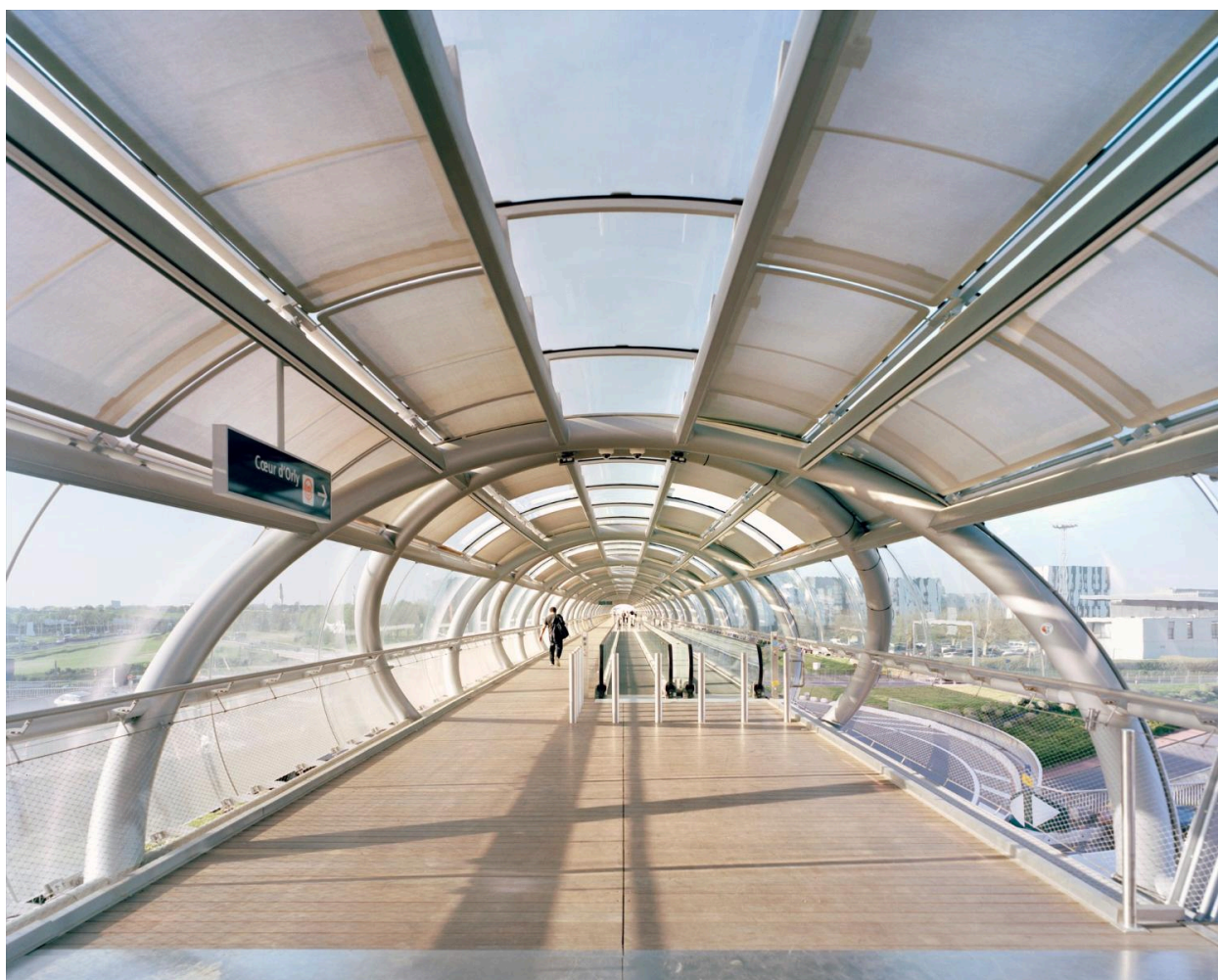
2018, intérieur de la la passerelle "cœur d'Orly" vue depuis le sud.
