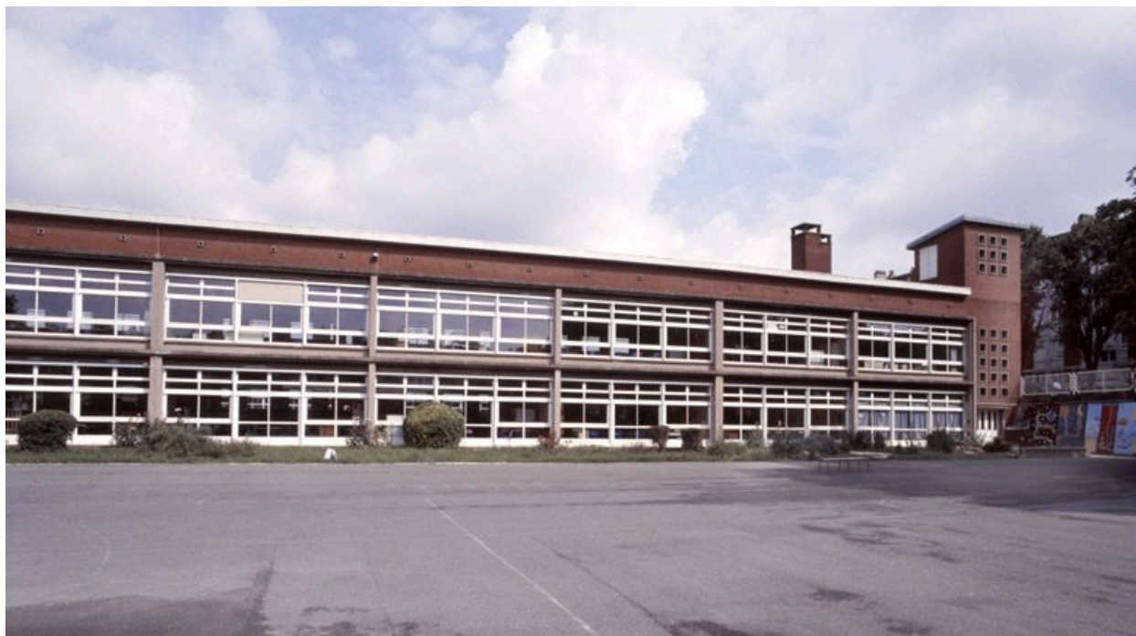
Groupe scolaire Joliot-Curie, rue Irène Joliot-Curie. Julien Heulot (architecte communal). Vue plus rapprochée du bâtiment de classe.
