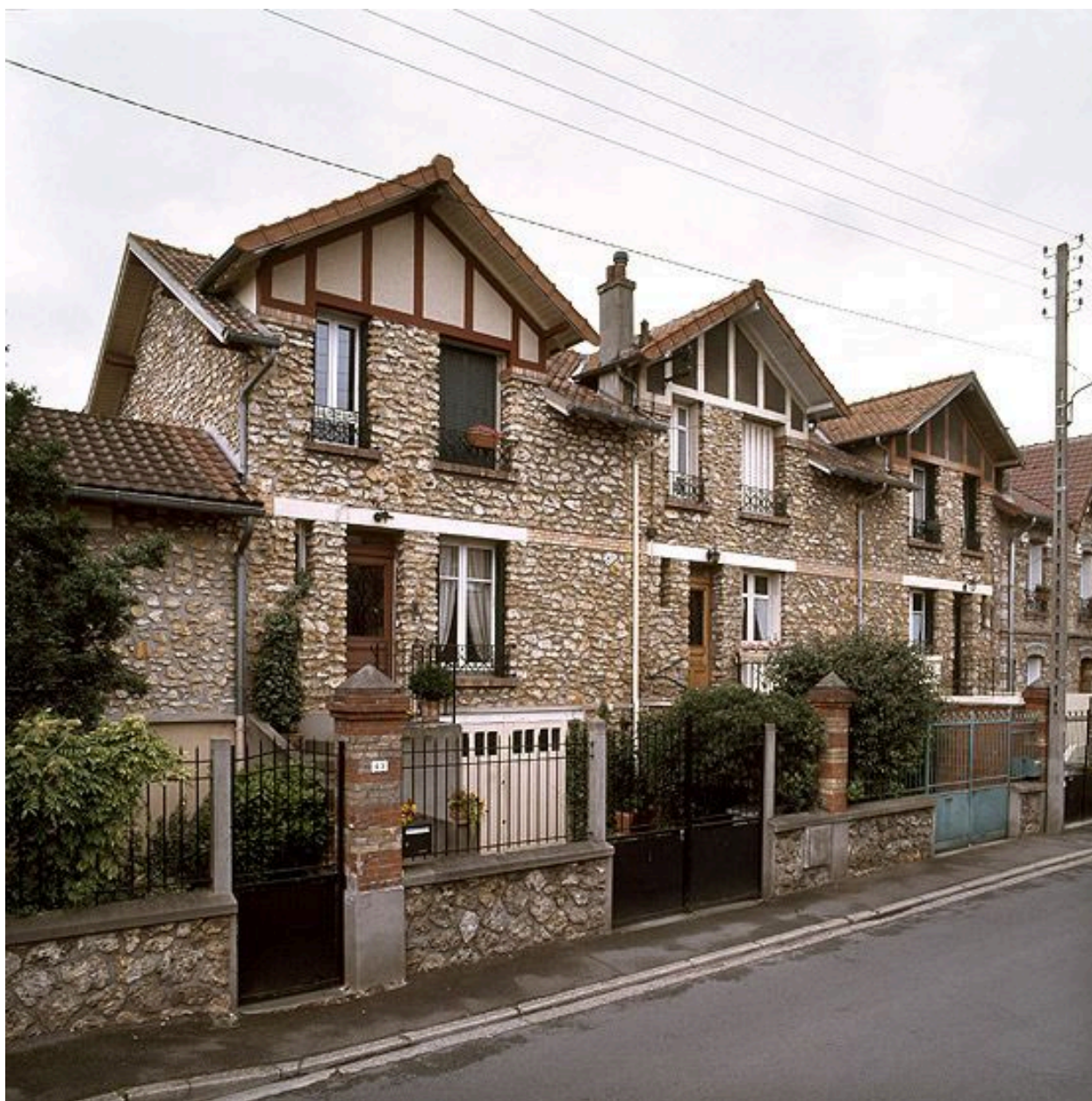
Andrésy. Façades principales, 43-47 rue du Maréchal-Gallieni.
