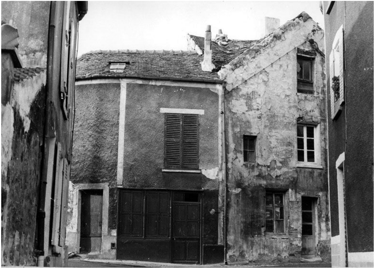
Andrésey. Maisons de la rue de l'Eglise. Photographie prise lors du pré-inventaire. Photographie. (Région Ile-de-France, Service Patrimoines et inventaire, Cote Pré- Inventaire).
