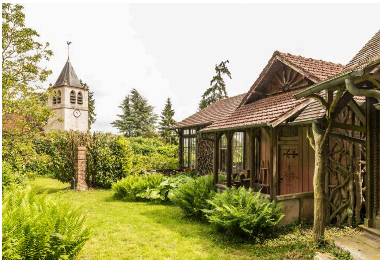
Vue générale des ateliers (5)
