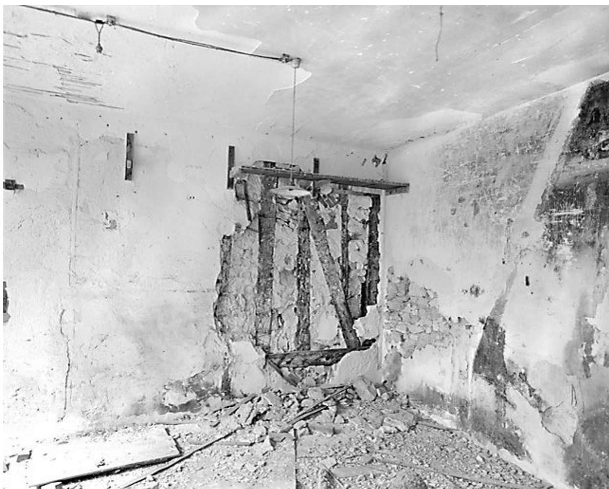
Vue intérieure de l'atelier occupant le rez-de-chaussée du logis 3 : mur en pan de bois.
