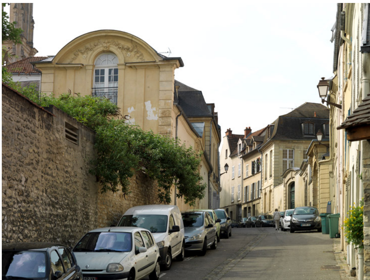
Vue de l'implantation de l'hôtel dans la rue Baudin.
