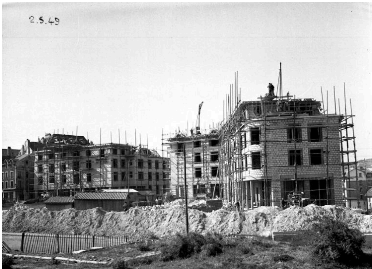
Les immeubles en cours de construction (Fonds Bertin).
