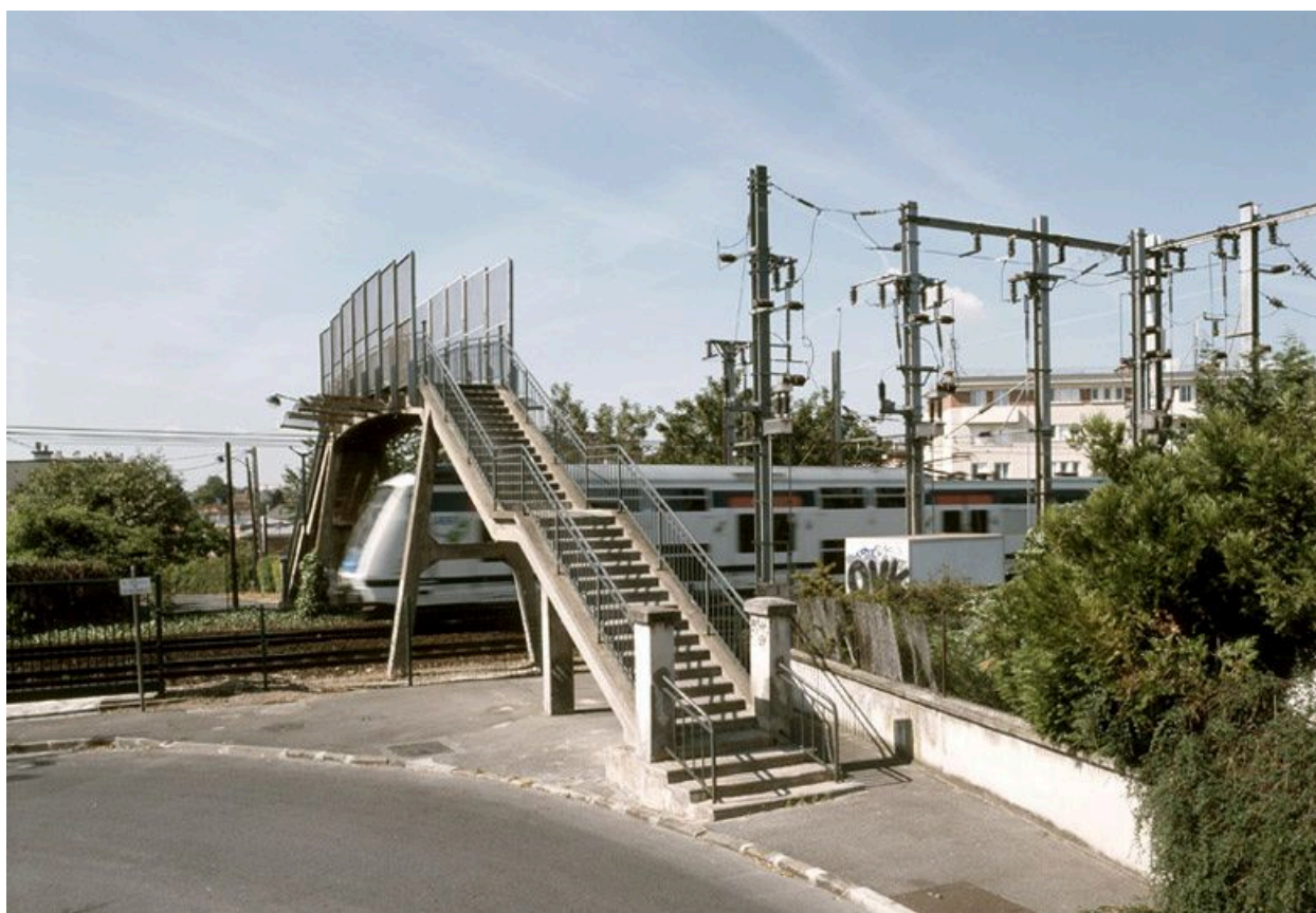
Passerelle piétonne SNCF, rue Eugène Varlin et rue Hauts-de-Bonne-eau.
