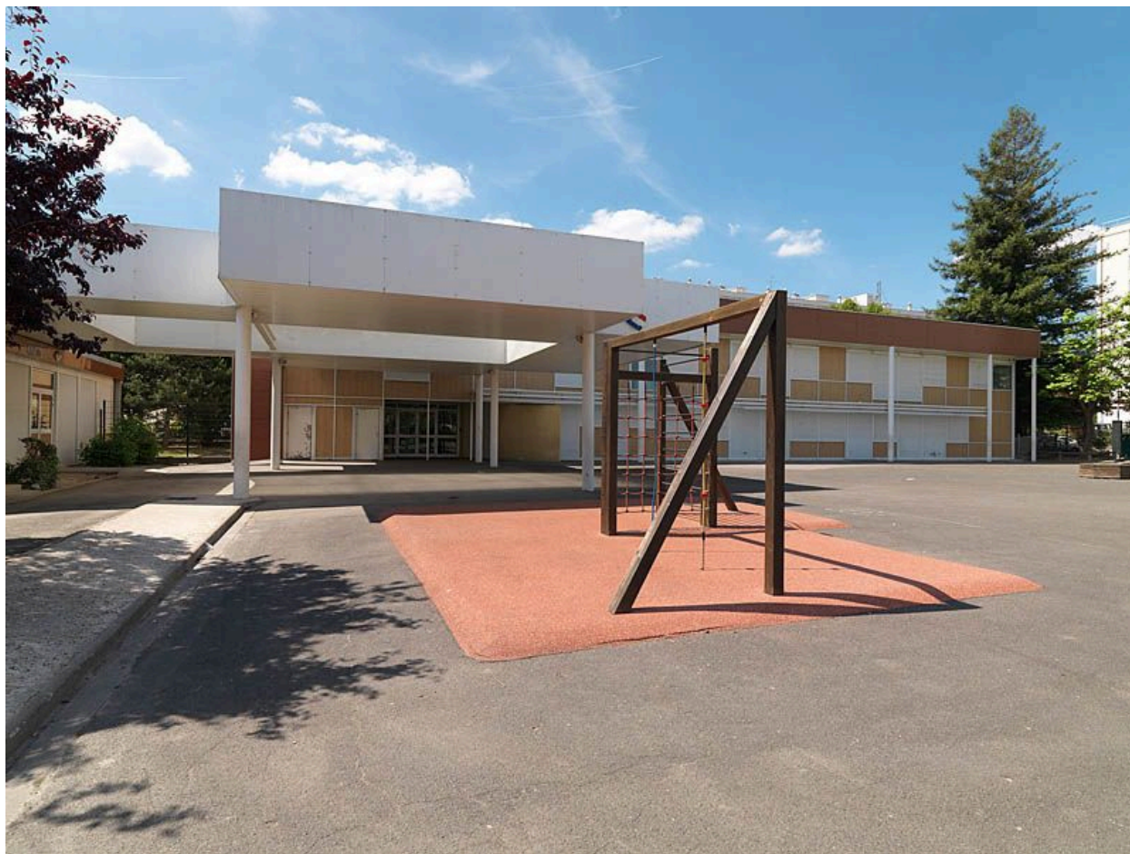
Cité dite Résidence Saint-Hubert. Cour et partie rénovée du groupe scolaire adjacent à la Résidence Saint-Hubert.
