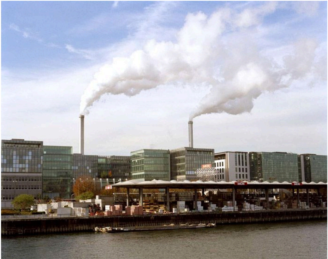
Ivry-sur-Seine. Vue rapprochée du quai d'embarquement de marchandises.
