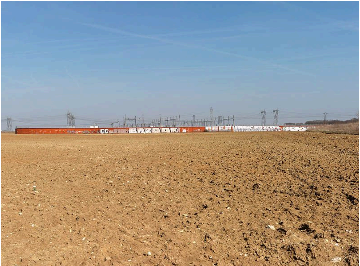
93, Tremblay-en-France. Poste électrique, champs.
