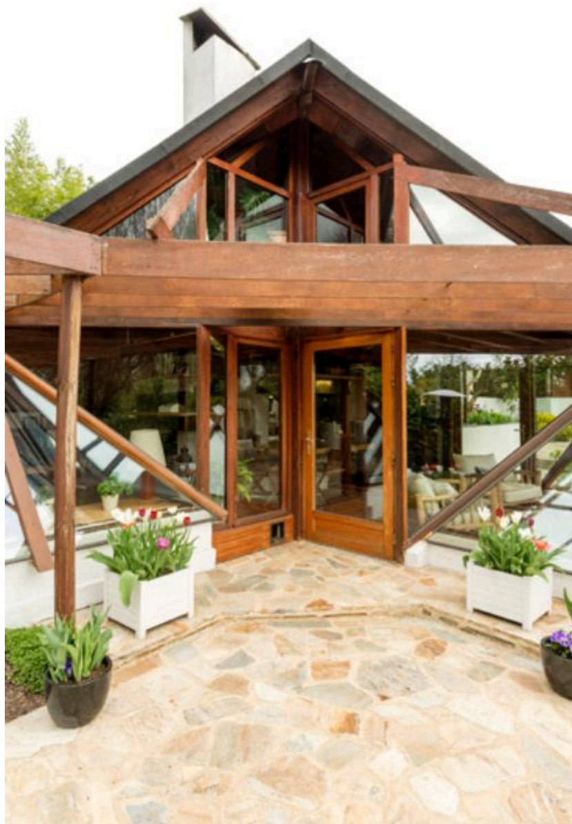
Vue de la façade latérale gauche : détail des baies vitrées.
