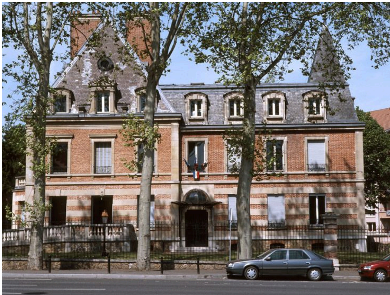
Le logement patronal, seul vestige conservé de la brasserie Gruber.
