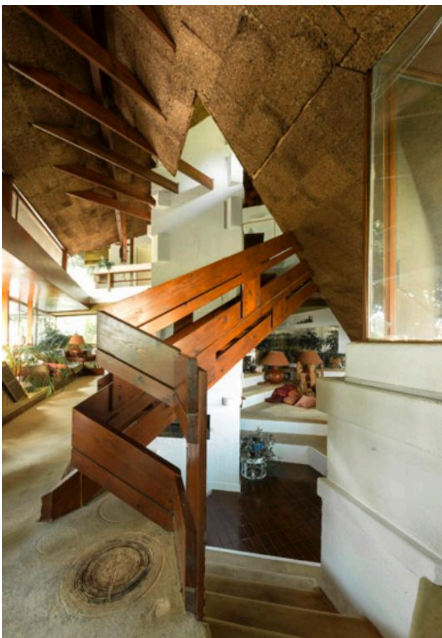
Vue du départ de l'escalier menant à la mezzanine (double) et du plafond recouvert de liège.
