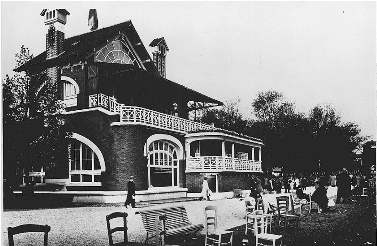
Façade postérieure du pavillon de pesage. Carte postale. (Soc. hist. de Villiers-sur-Marne et de la Brie française)
