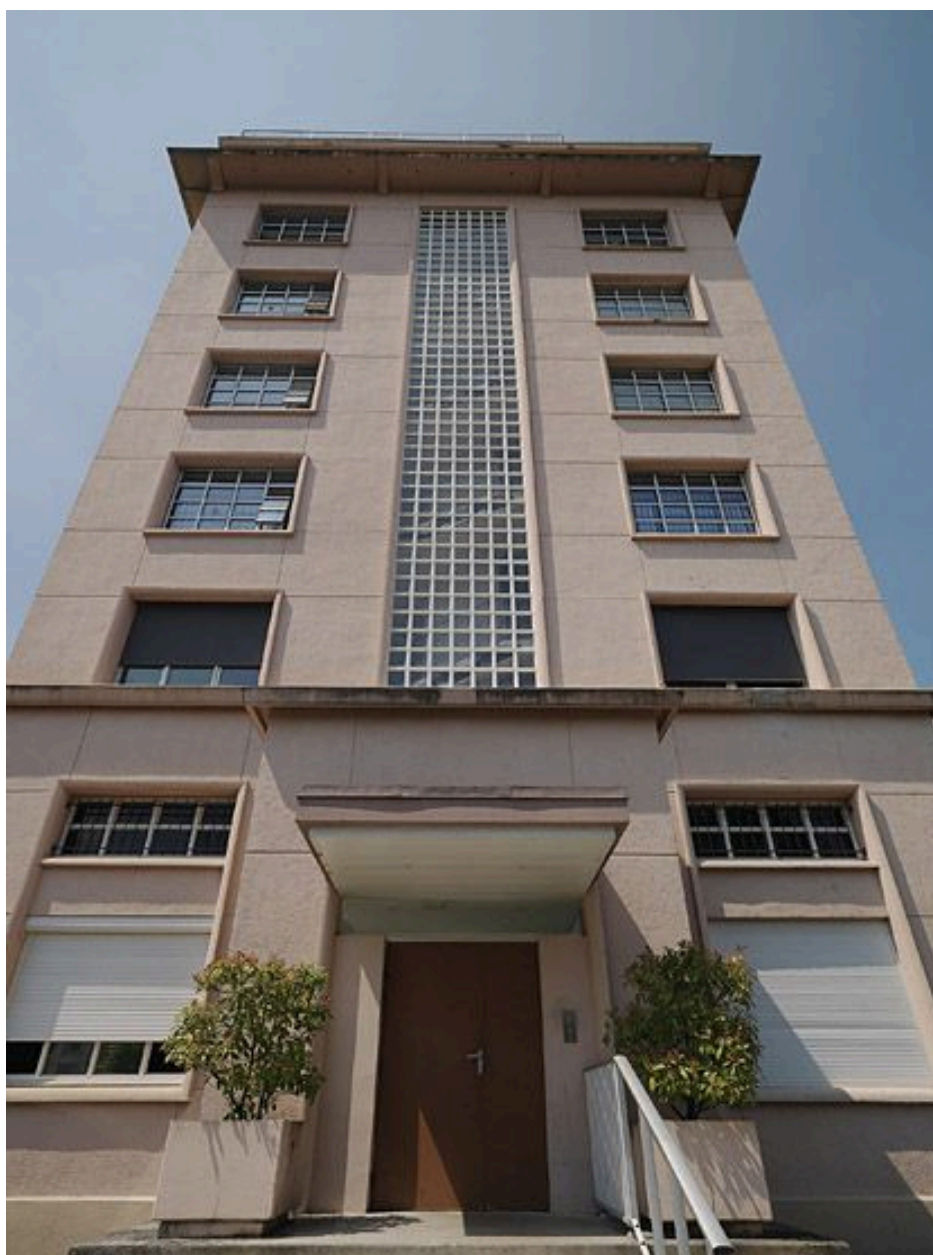
Extension PIC, depuis le sud.
