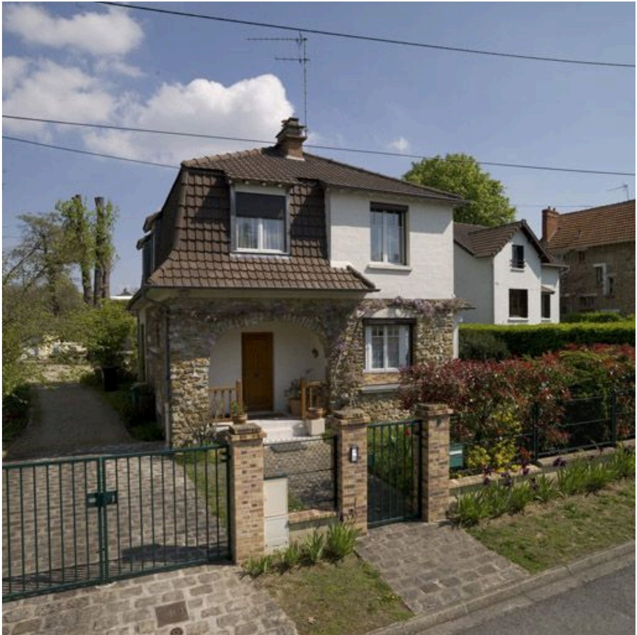
Vue d'ensemble d'un pavillon en meulière et pierre reconstituée, 9 allée des Vergers. Un arc en plein cintre forme un porche sur la façade principale.
