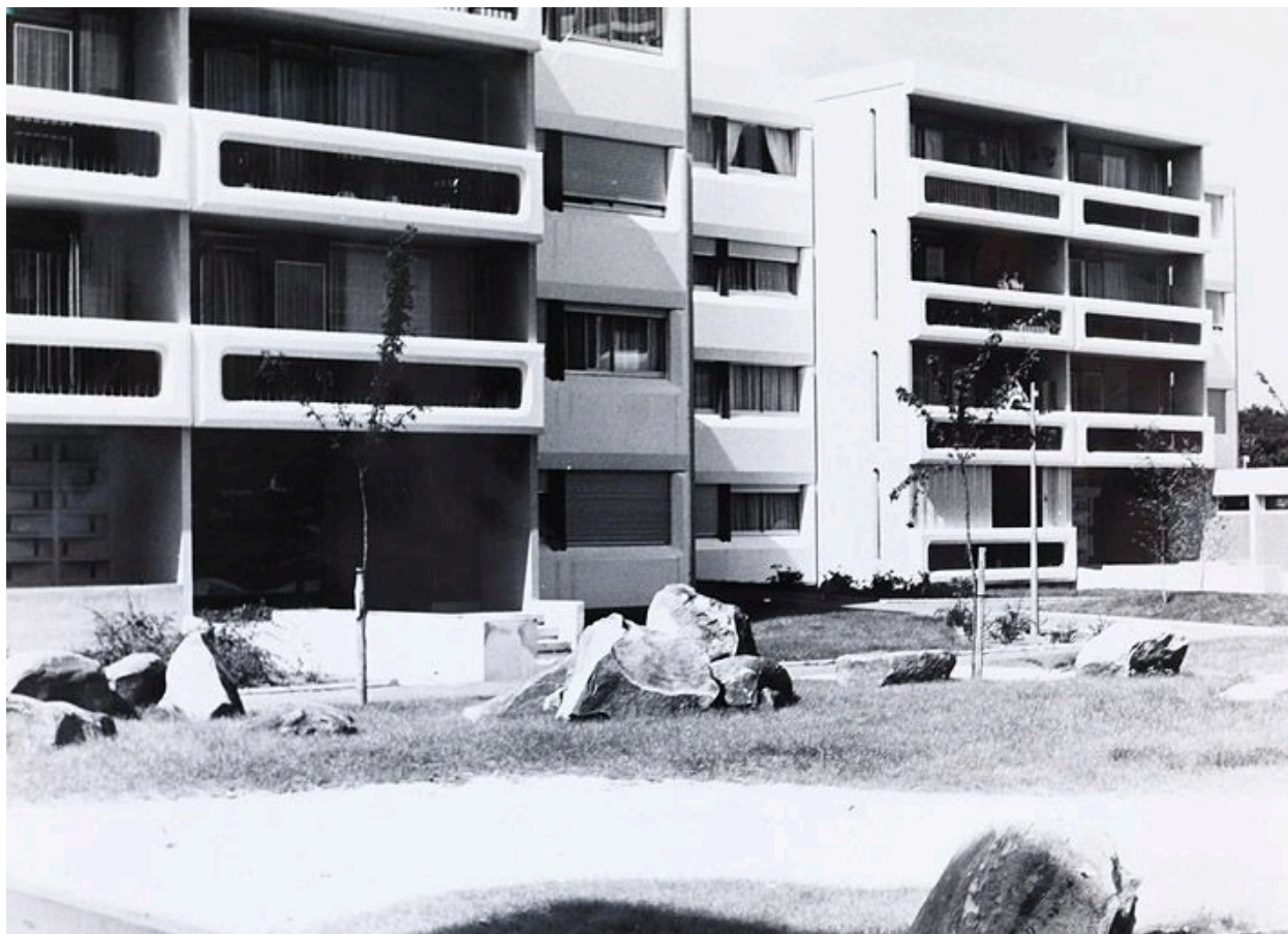
Projet pour Meaux Beauval. (Cité de l'architecture et du patrimoine. fonds DAU 173/1)
