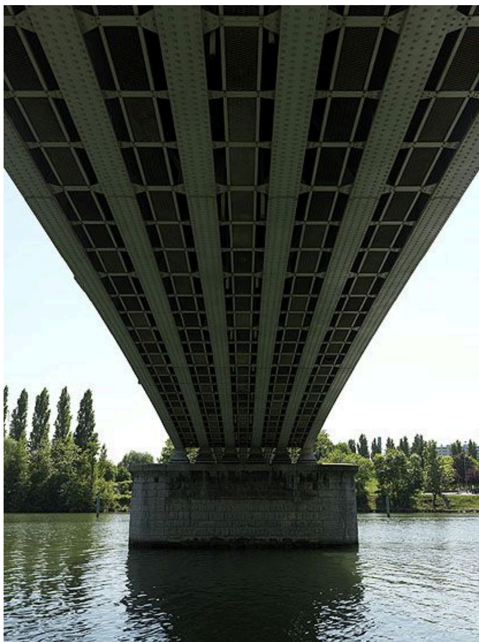
Choisy-le-Roi. Pont ferroviaire de la grande ceinture. Vue du dessous du tablier.
