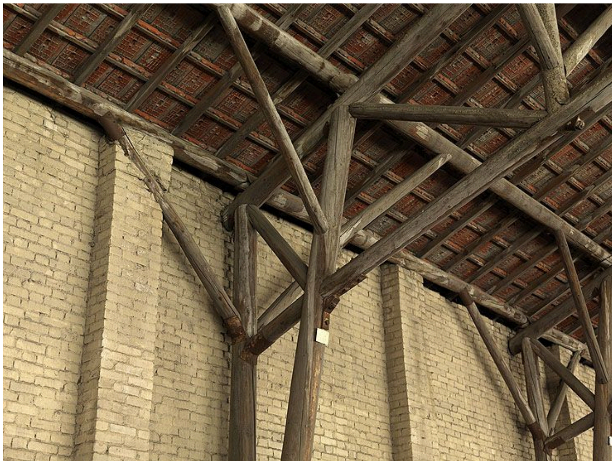
Choisy-le-Roi, entrepôt industriel de l'ancienne faïencerie Boulenger XX, 138 avenue de Villeneuve-Saint-Georges. Halle à la charpente en rondin dite canadienne.
