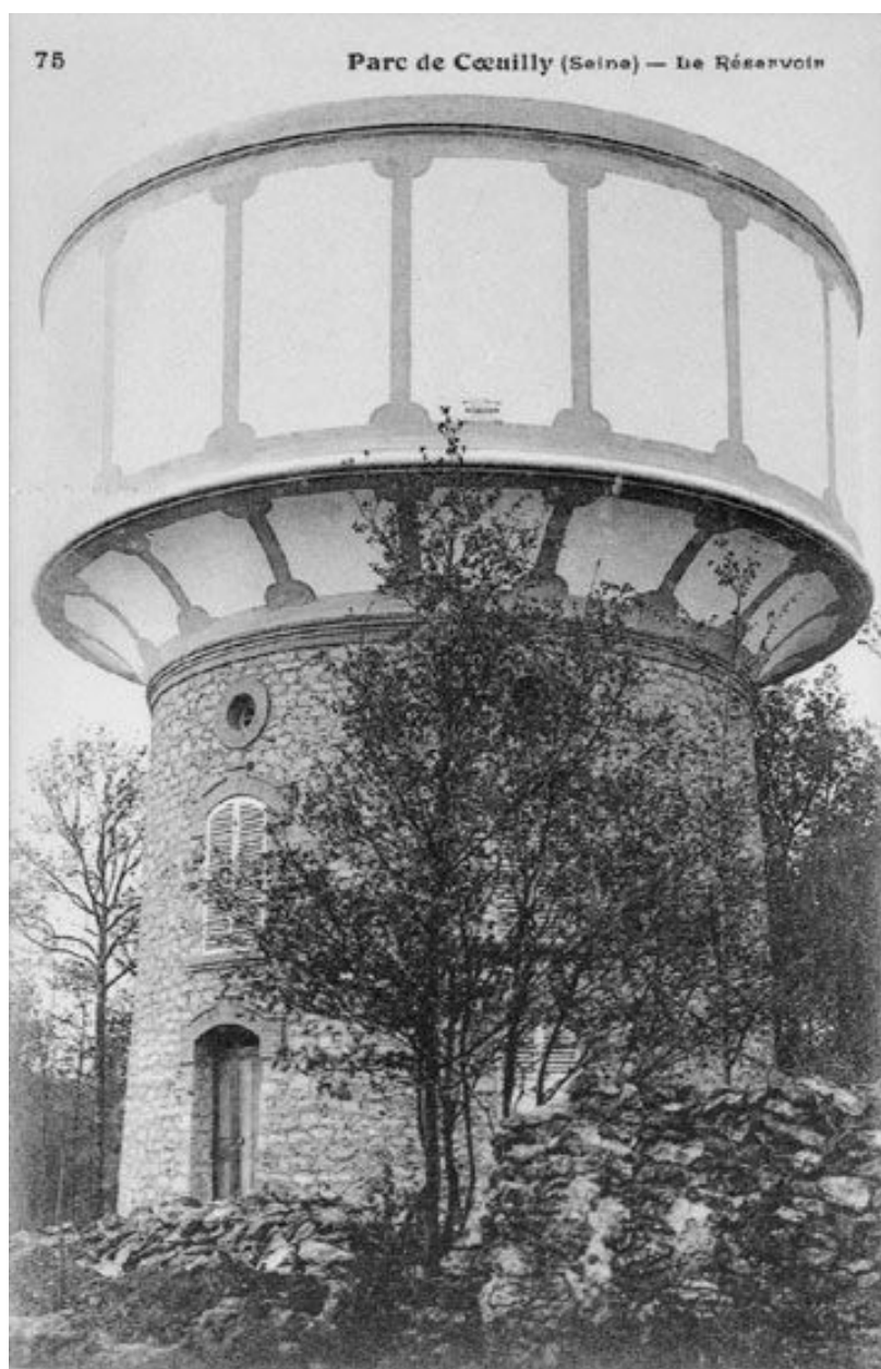
Le réservoir du parc de Coeuilly. Carte postale. (AD Val-de-Marne. 2Fi Champigny 302)
