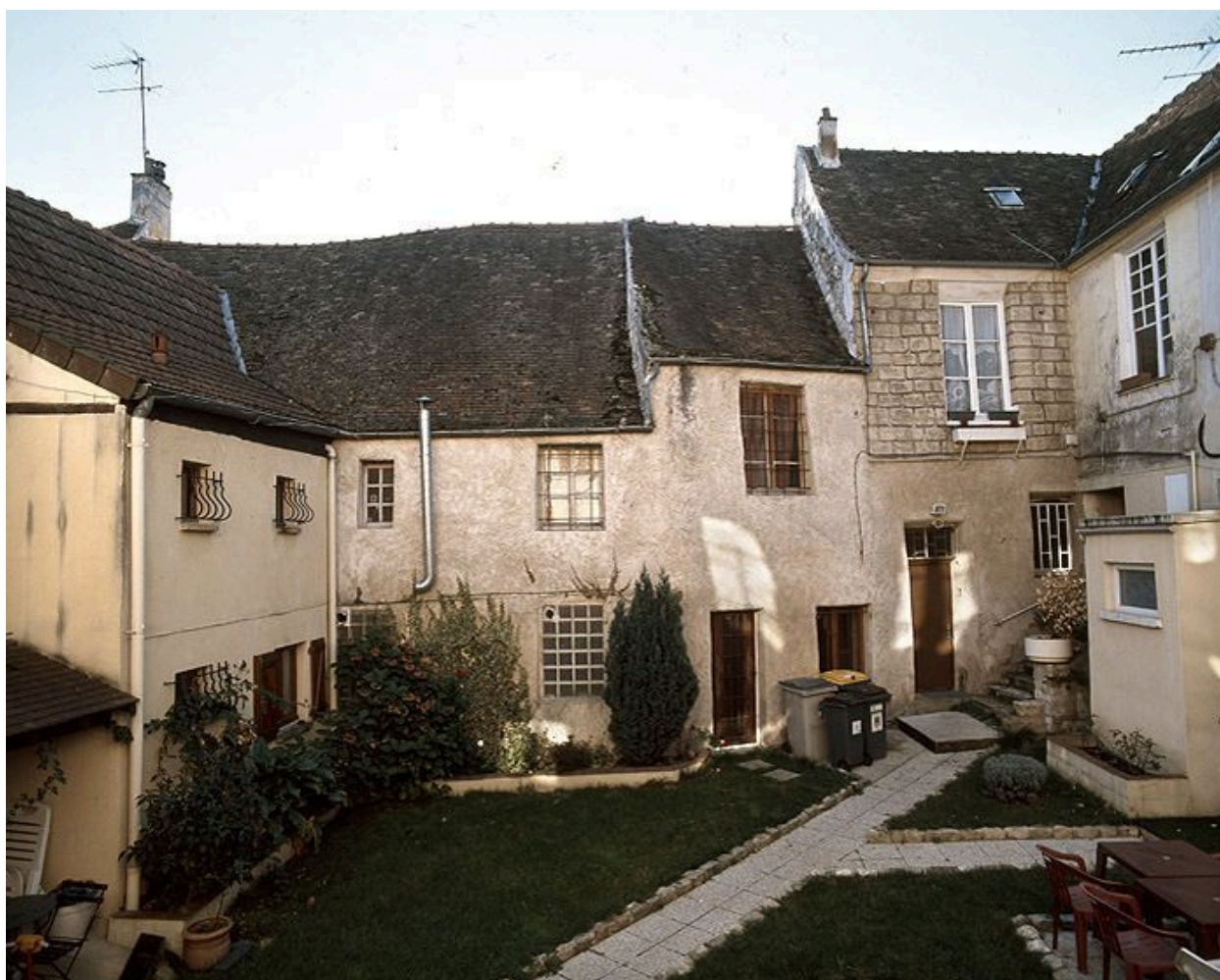
Les bâtiments sur cour de la partie occidentale.
