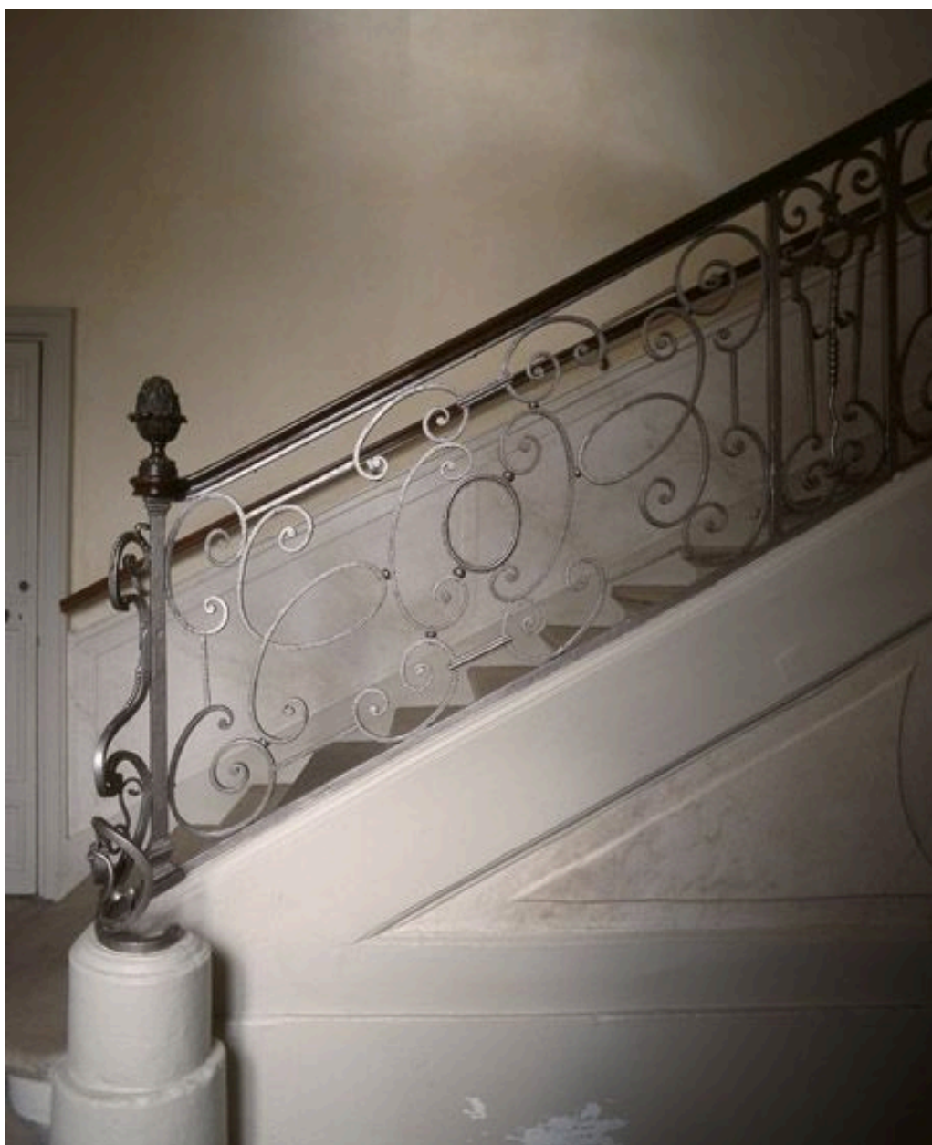
L'escalier intérieur situé à droite dans le hall d'entrée : détail de la rampe en fer forgé.
