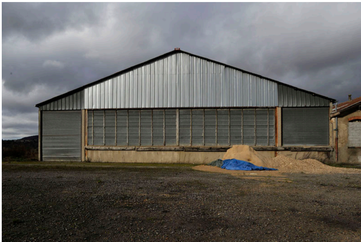
Achères, entrepôt agricole, chemin des Hautes-Plaines. Vue de la façade de la partie neuve.
