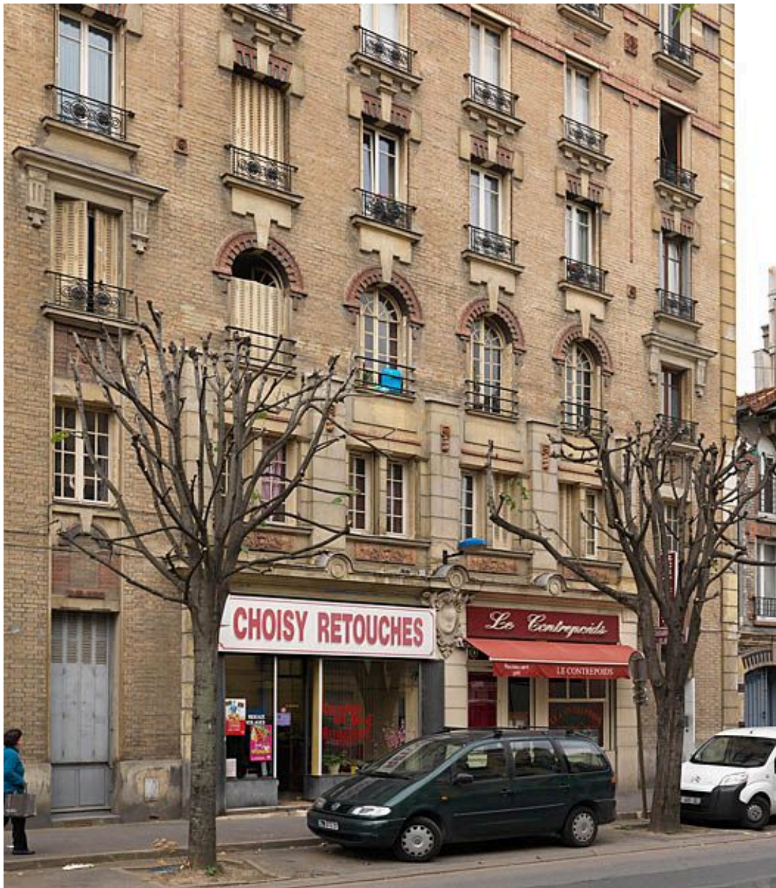
Choisy-le-Roi, immeuble, 30 avenue Anatole France. Vue d'ensemble, détail de l'entrée.
