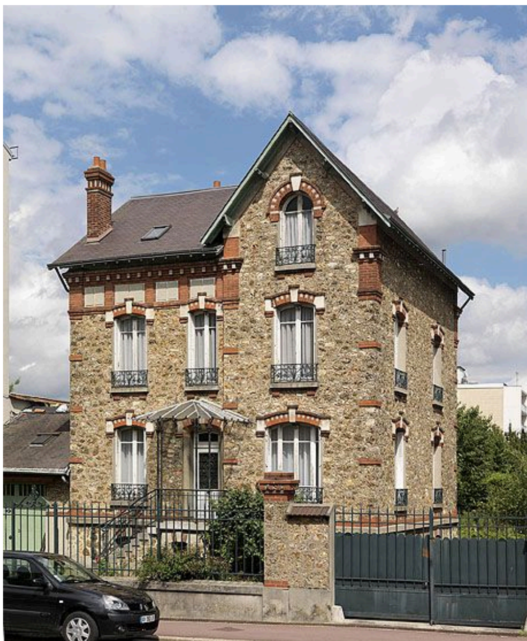
Maison 9bis quai Jacques-Prévert : vue d'ensemble. Villa en meulière apparente, construite en bords de Marne, vers 1900.
