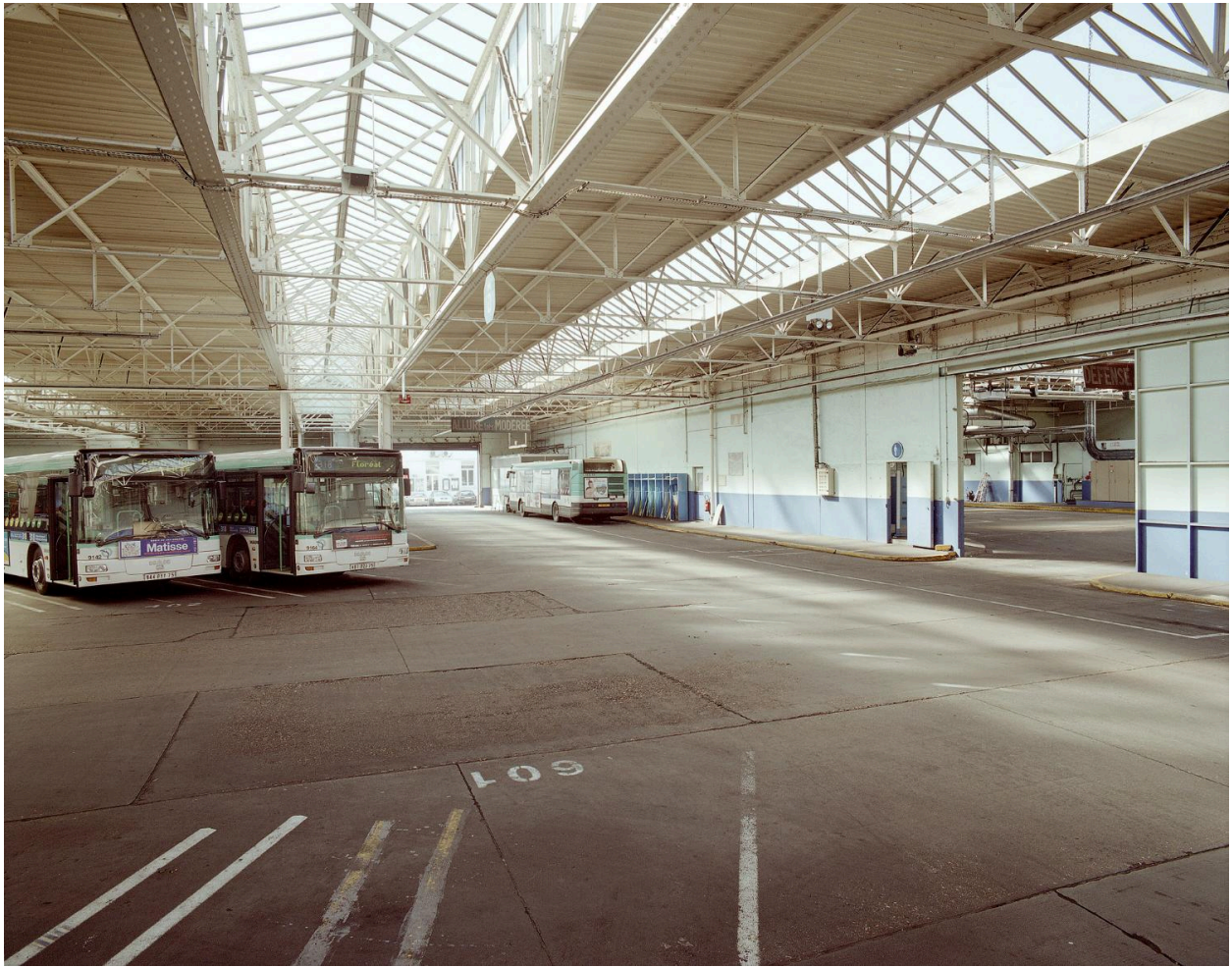
Intérieur du "hall de remisage".
