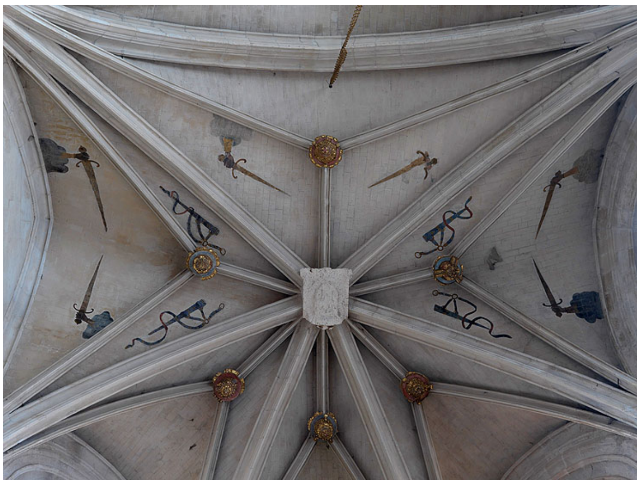
La voûte de l'abside.
