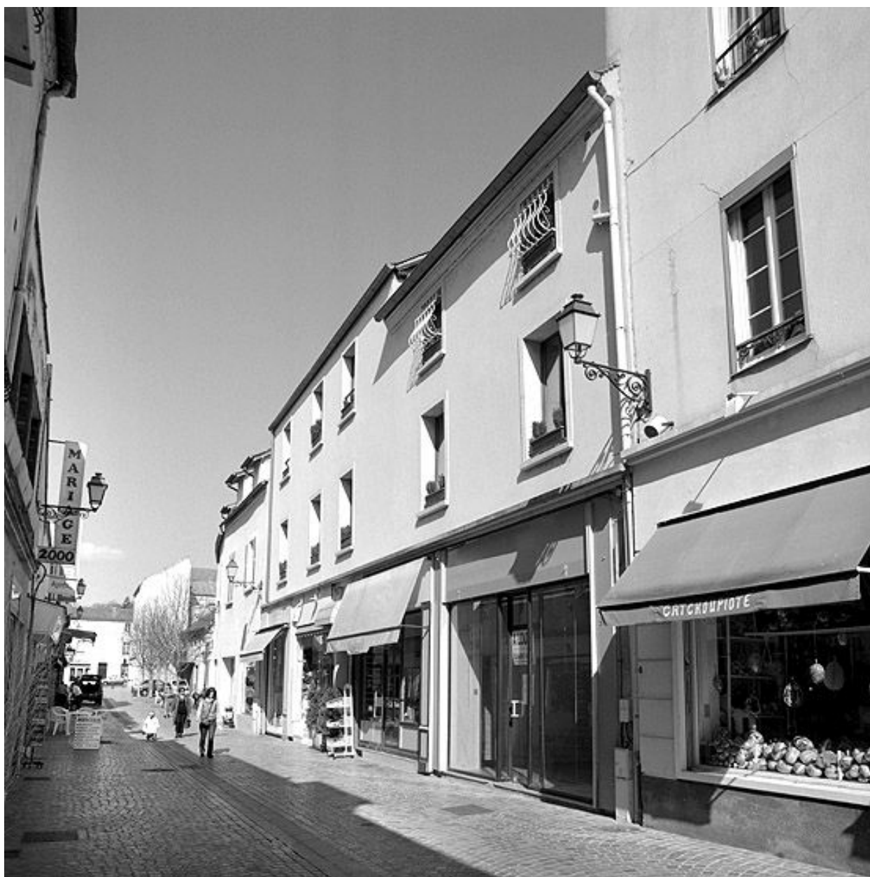
La façade, vue du sud-est.
