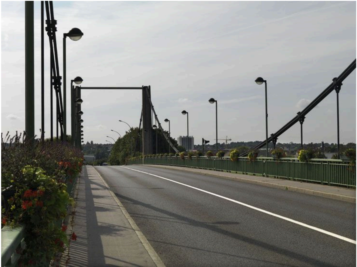
Chaussée du pont bordée par les câbles de retenue et leurs suspentes.
