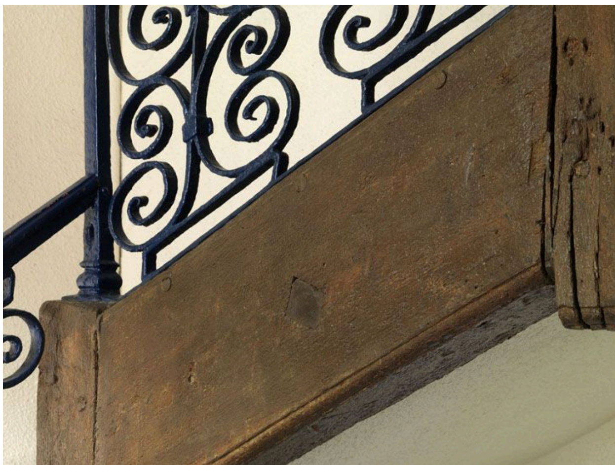
Détail du limon avec les traces de cheville.
