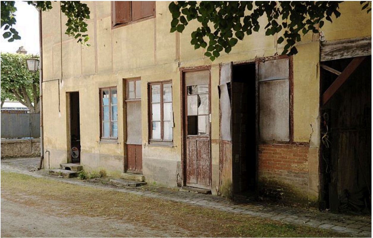
Atelier principal, partie réservée au logement des ouvriers.
