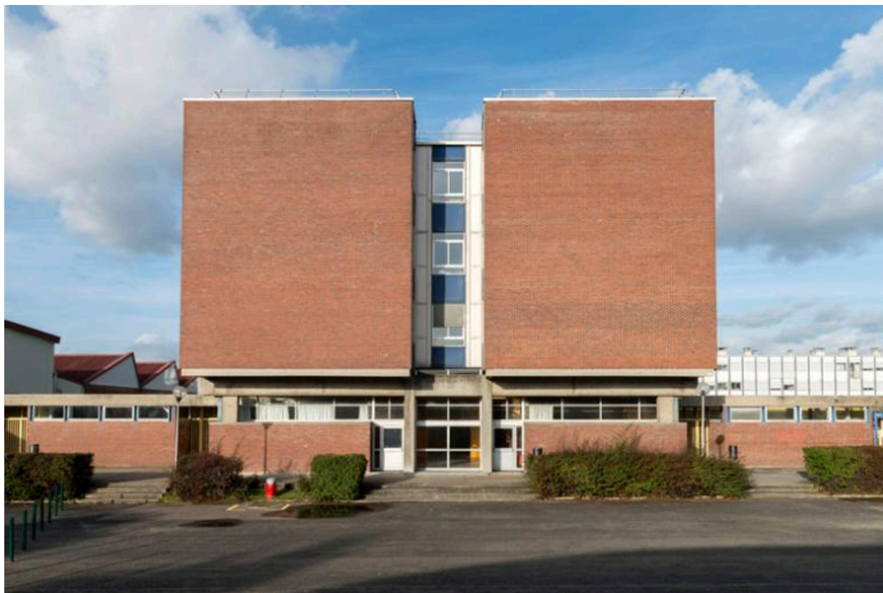
Lycée Rostand : les murs pignons aveugles en brique du bâtiment principal.
