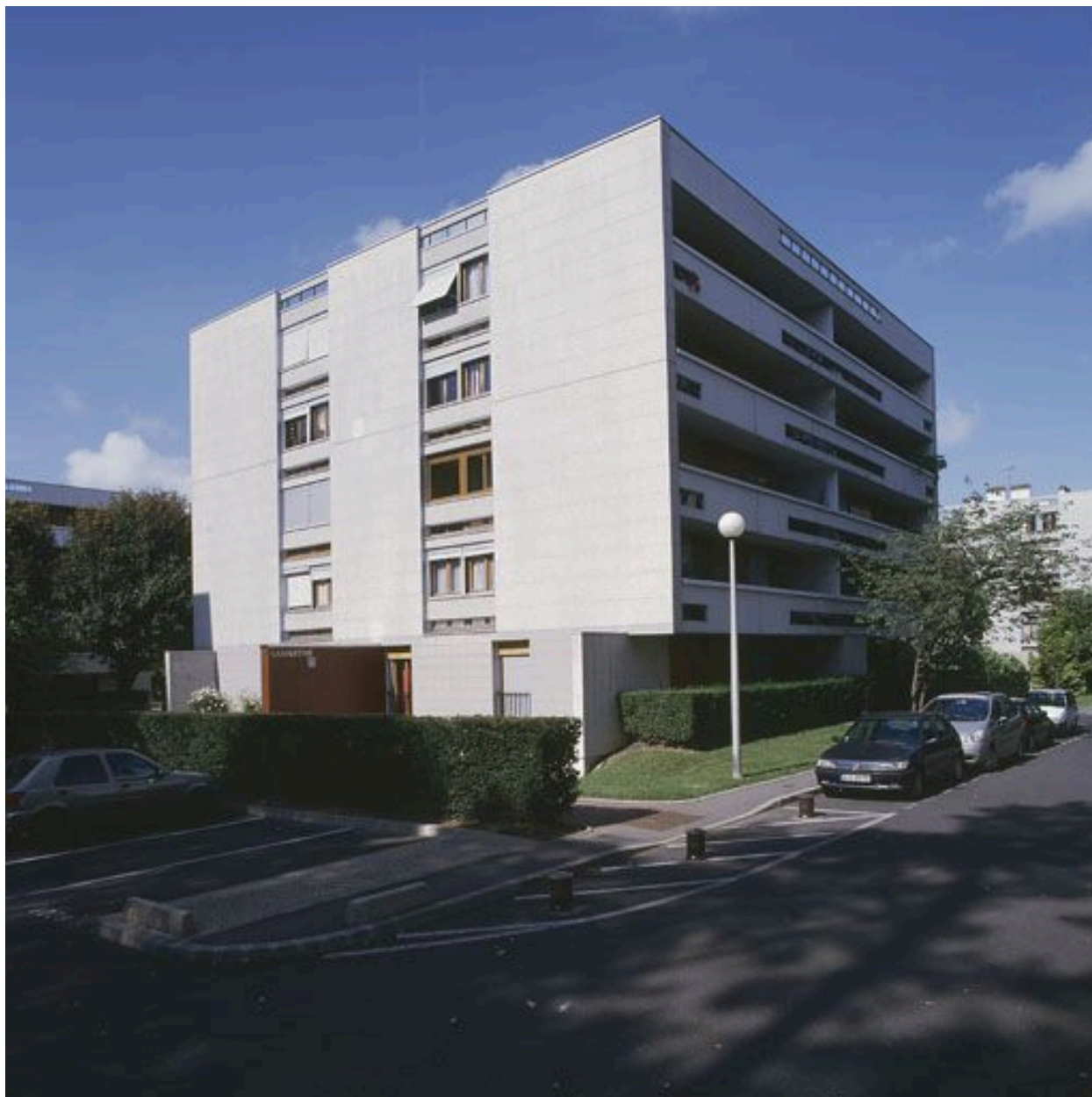
Vue d'ensemble d'un des 14 immeubles de plan carré à quatre étages sur re-de-chaussée.
