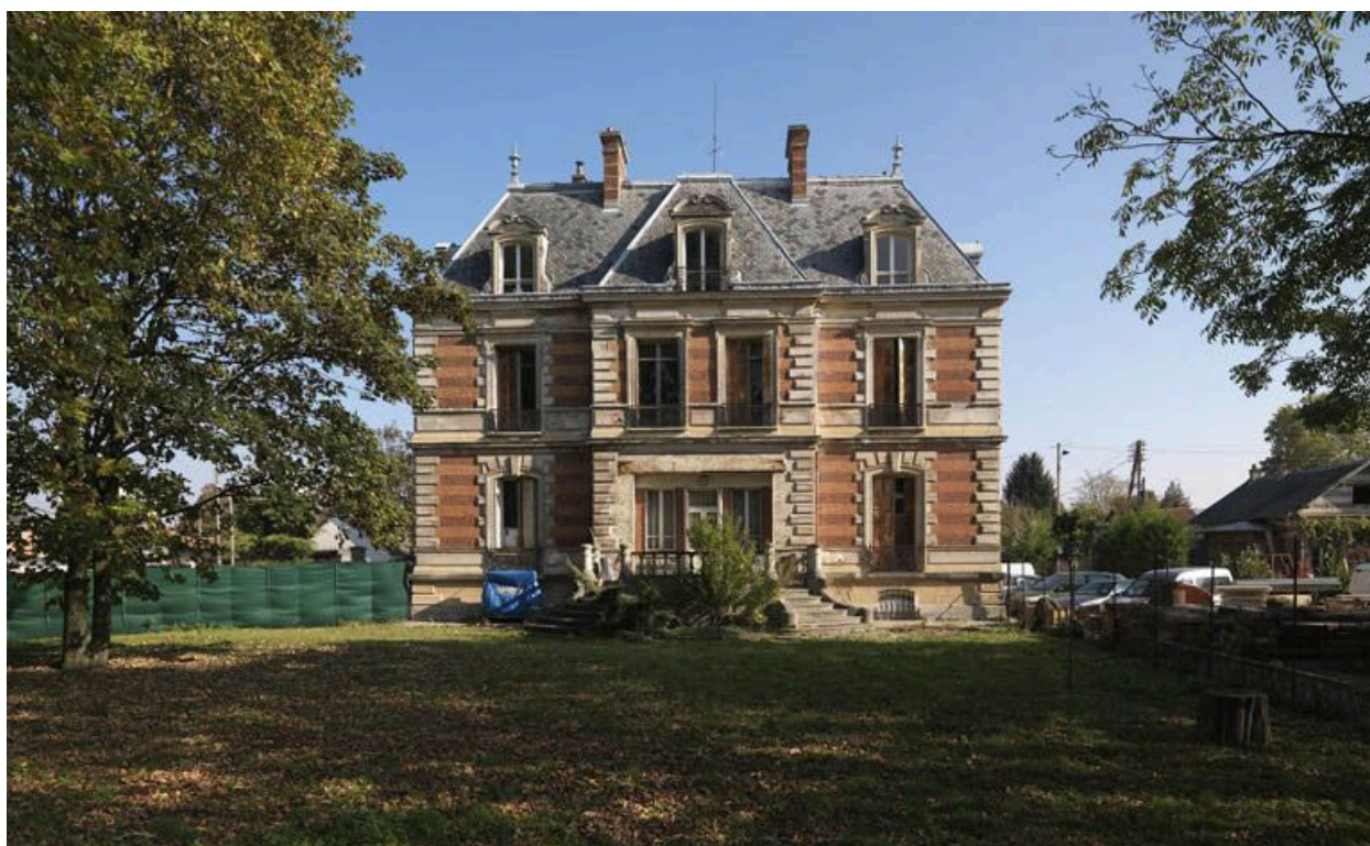
Vue de la façade latérale sud.
